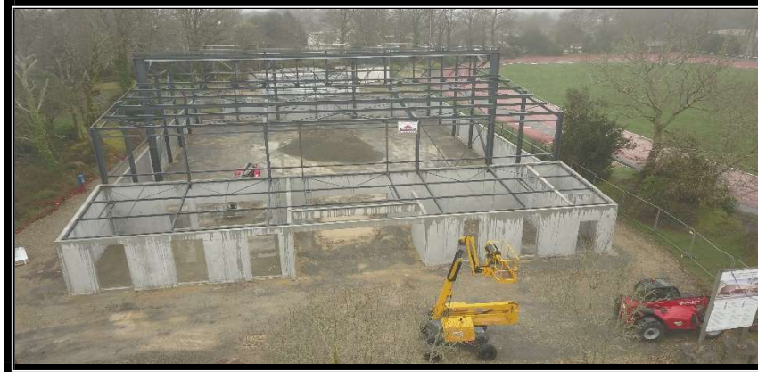
Photo du chantier des terrains de padel
